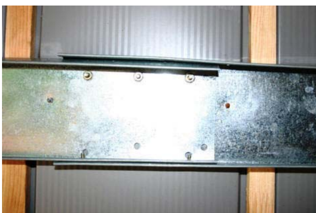
Vue sur l'assemblage central des poutres
