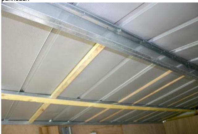
Vue d'ensemble après retournement des poutres du milieu des panneaux
