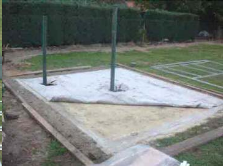
J'ai utilisé des chevrons de 60 X 85 pour délimiter le pourtour de la zone du chantier et surélever l'abri. On aperçoit sur cette photo les chevrons, le cadre en béton armé et le sol damé et roulé au gravier.
