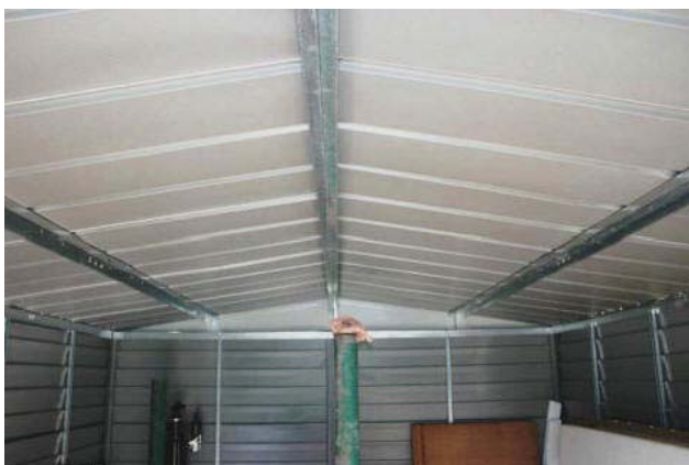
Vue d'ensemble après retournement des poutres du milieu des panneaux
