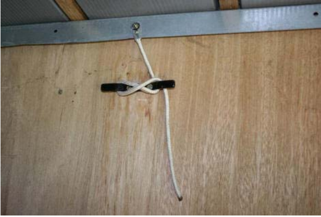
Vue sur une fixation du toit avec un taquet d'amarrage.
