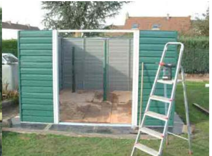
Vue avant, les quatre murs, le plancher sont montés. A l'aide d'une perceuse visseuse dévisseuse, il est facile d'assembler cet ensemble métallique. La rigidité de la construction est remarquable. J'ai également prévu de doubler les parois avec du polystyrène et du contreplaqué. Cela se fera au printemps prochain dès que le temps le permettra. Mais avant, il faut bien réfléchir à l'agencement définitif, et au passage des câbles électriques permettant d'alimenter, le télescope, l'éclairage, l'ordinateur et tout ce qui peut être nécessaire pour passer les soirées.
