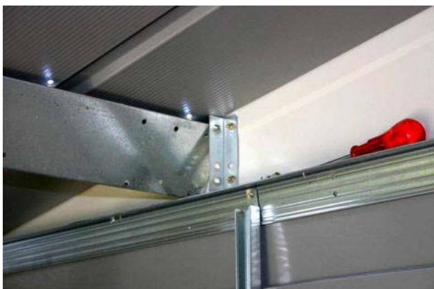
Mise en place des poutres de milieu de panneaux.
