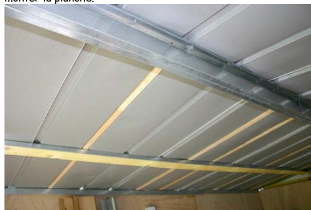
Renforcement des panneaux.
