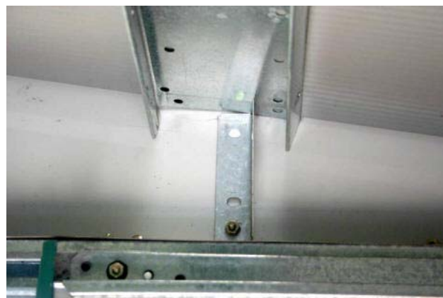
On se servira des équerres de renforts pour positionner la poutre.
