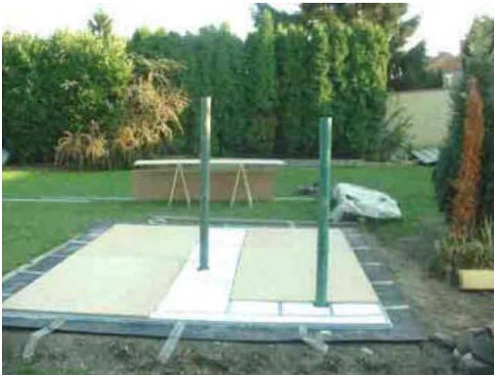
Vue arrière. Le plastique est posé sur le sol suivi d'une feuille d'isolant en tissu polymère. Ensuite le support de plancher est assemblé et vissé dans le béton avec des chevilles. Des plaques de polystyrène sont découpées et posées dans les alvéoles puis le plancher est découpé suivant les spécifications du constructeur. Il faut penser à faire les découpes de passage des poteaux le plus justement possible (Pour ma part, le diamètre des poteaux + 2 centimètres). On pourra si l'on est figoleur combler ce jour avec de la mousse caoutchoutée (joint de portière de voiture).
