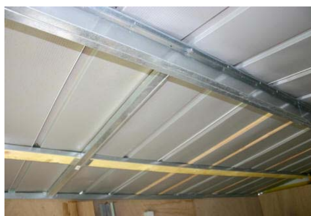
Renforcement des panneaux.
